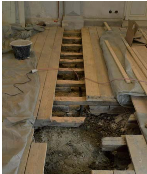
Der offenliegende Fußboden in der Küchenecke, Foto Dr. Holger Zinke
